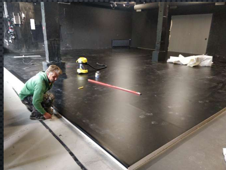
Jussi uuden lattian rakennushommissa
